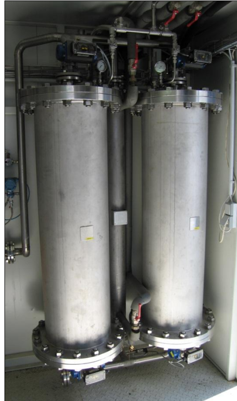
Jernoxid opsuger for den endelige biogas afsvovling
