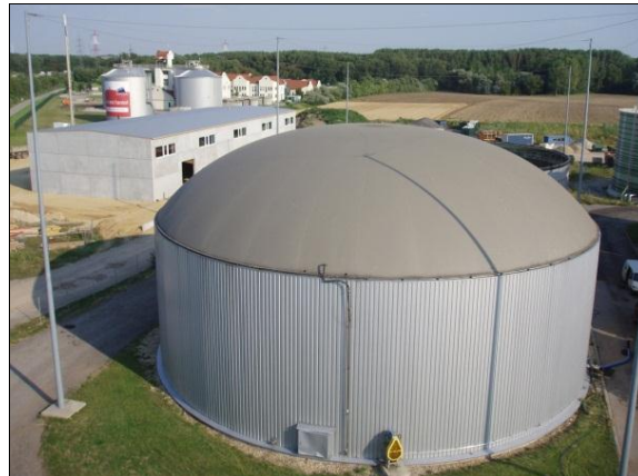
Sekundær rådnetank og gaslager
