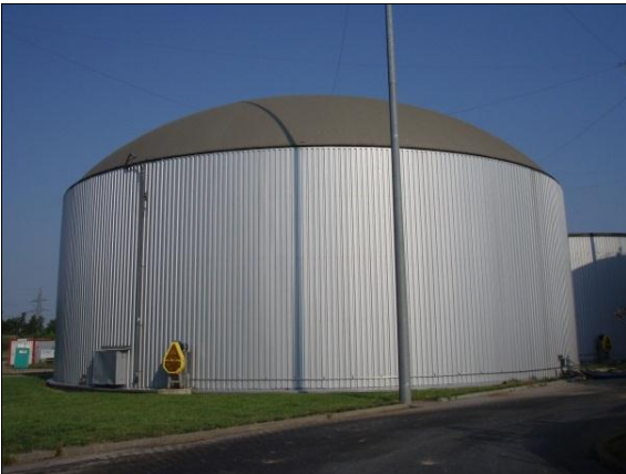
Sekundær rådnetank og gaslager
