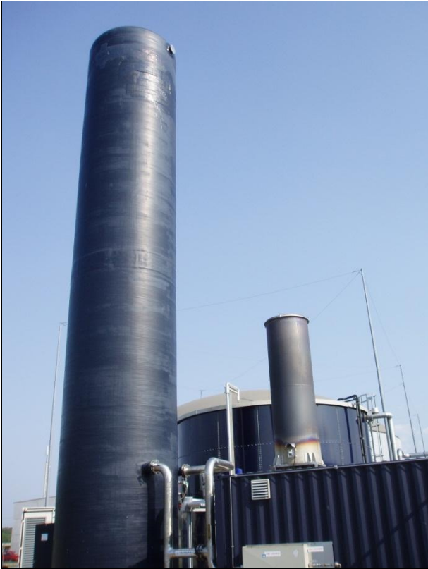
Biologisk skrubber for rå biogas afsvovling
